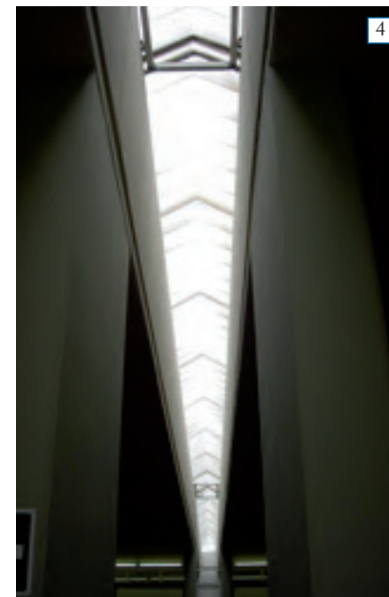
Fig.1, 2 - Neubau Fraunhofer ISE, Friburgo, Germania Fig.3 - Centro culturale Arena, Germania Fig.4 - Copertura a risega con lucernari, Italia, Fonte GSE
